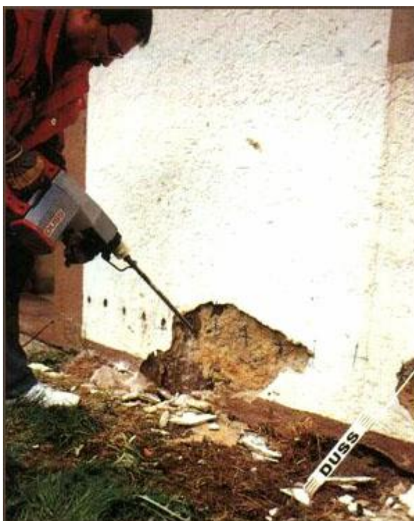
2. В зависимости от толщины стены и характера используемого материала в стене высверливаются отверстия на высоте 10 см от земли и на равном расстоянии друг от друга. Сверлить надо по наклонной вниз.
