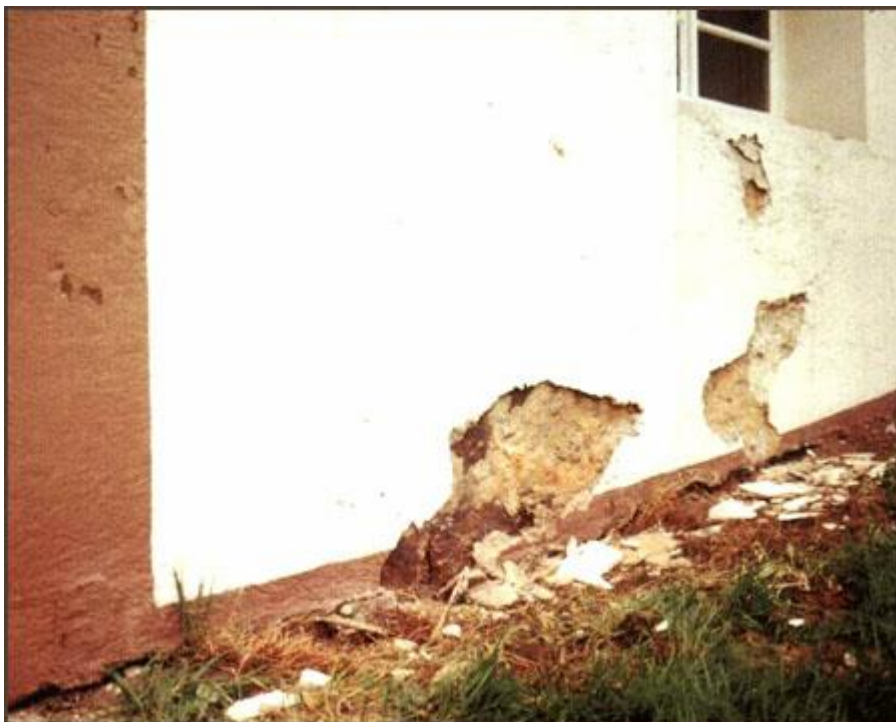
1. Сырая стена и последствия отсыревания: разрушающиеся штукатурка и кирпичная кладка.
